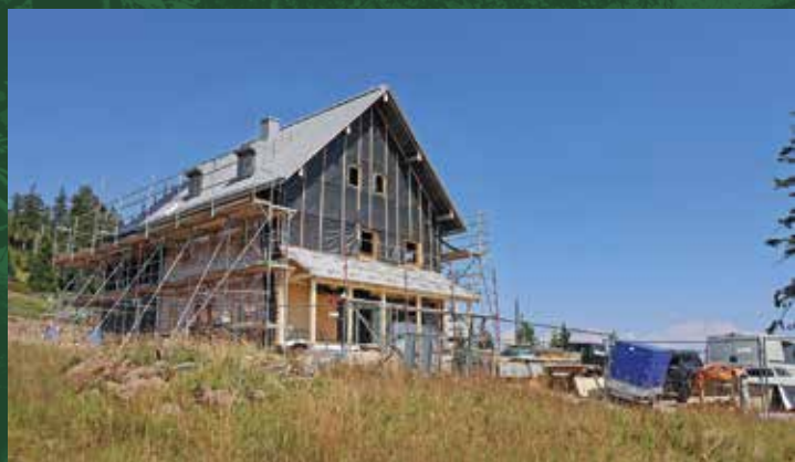
Emsiges Treiben herrschte jüngst auf der Baustelle unterhalb des Großen Rachels.
